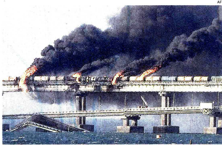
Camion bomba. Il ponte Kerch danneggiato e in fiamme dopo l'attacco
